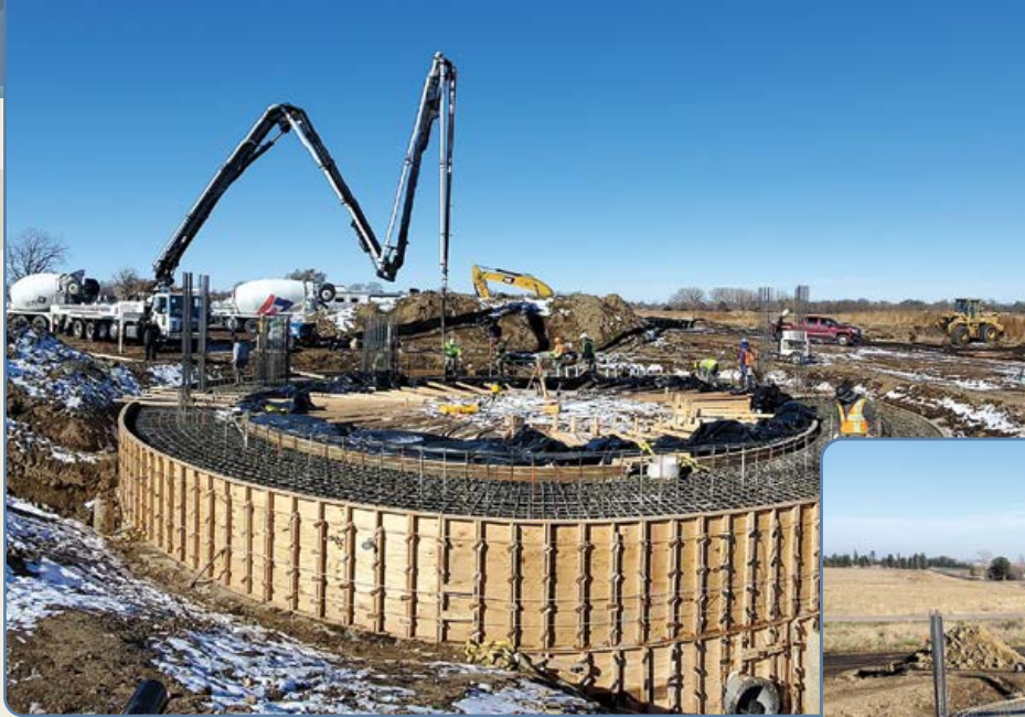
Pouring the foundation cap
