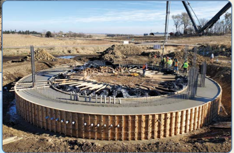
Pouring the foundation cap
