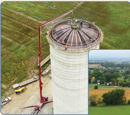
Pouring the dome cap
