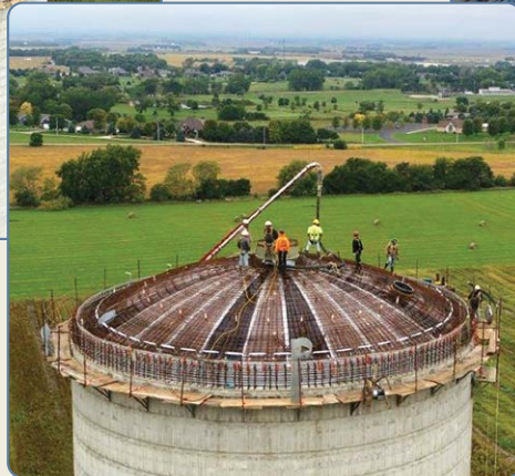
Pouring the dome cap
